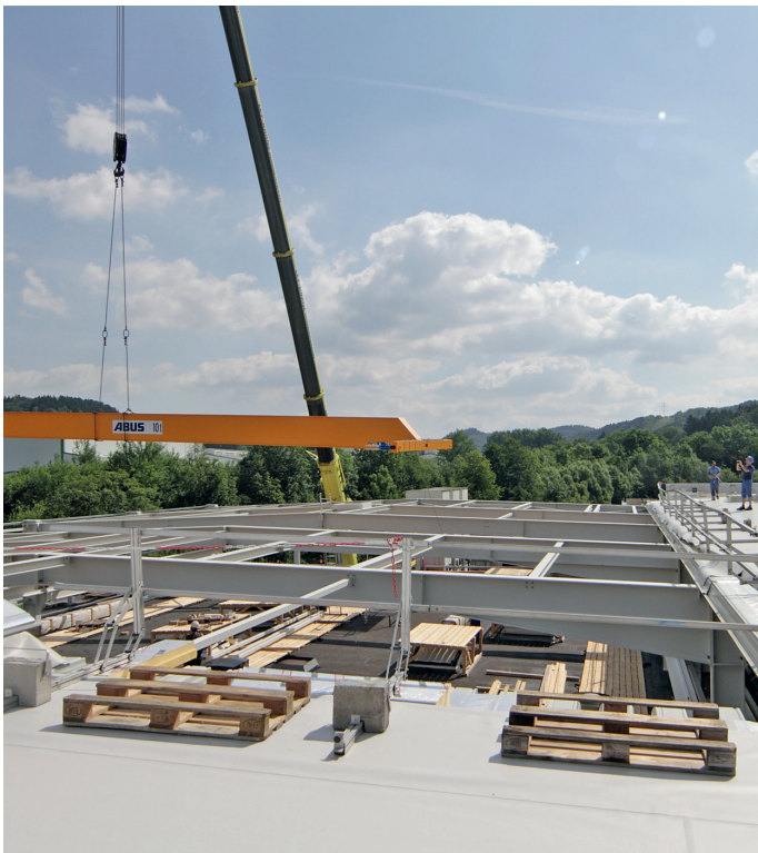
Die Montage eines Einträgerlaufkrans ist eine Sache von wenigen Stunden.
