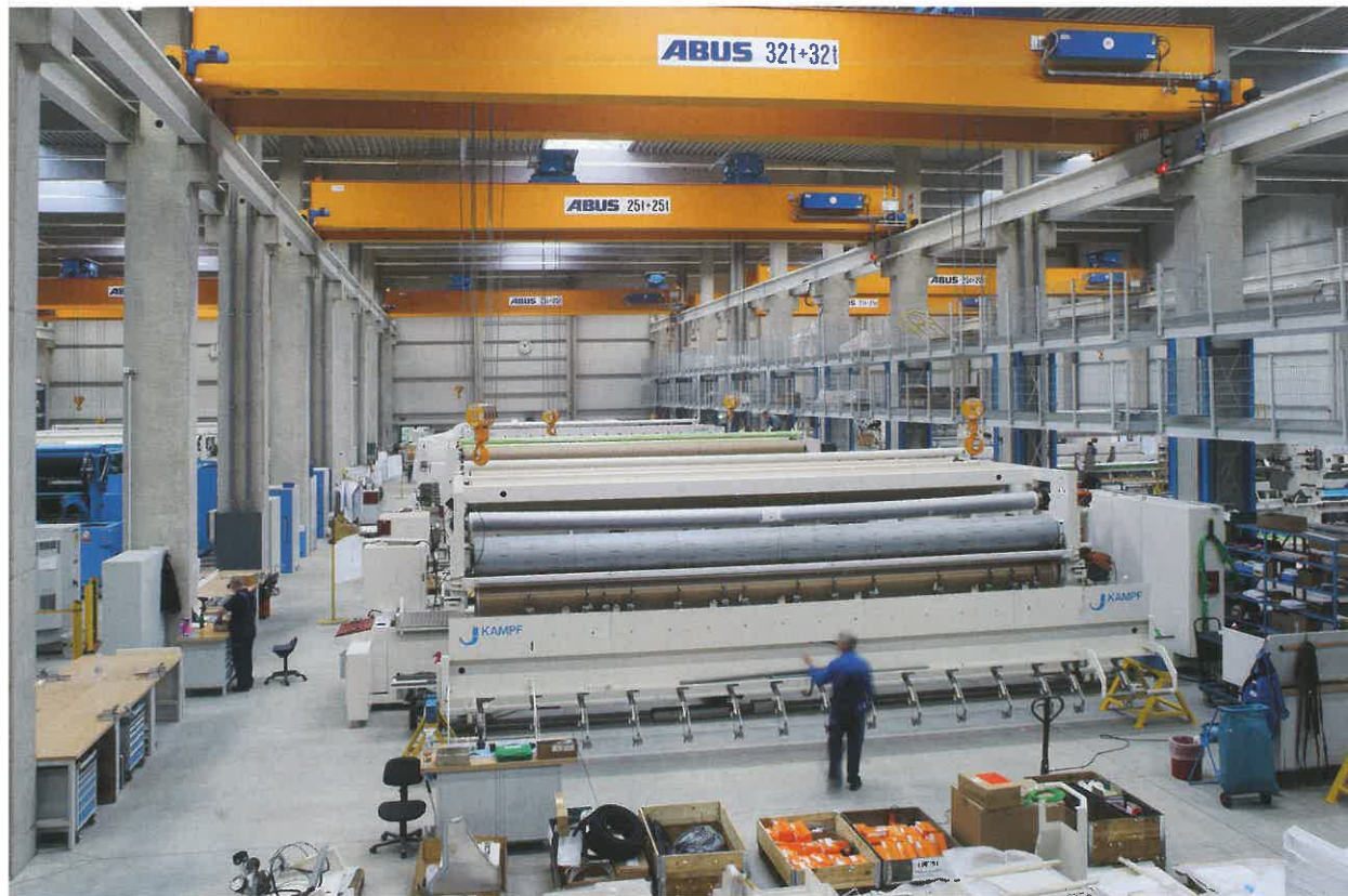
02 Bei weit auseinanderliegenden Anschlagpunkten kann durch den Einsatz von zwei Katzen auf eine Lasttraverse verzichtet werden – die Kransteuerung sorgt dabei für Gleichlauf von Fahrtrieben und Hubwerken
